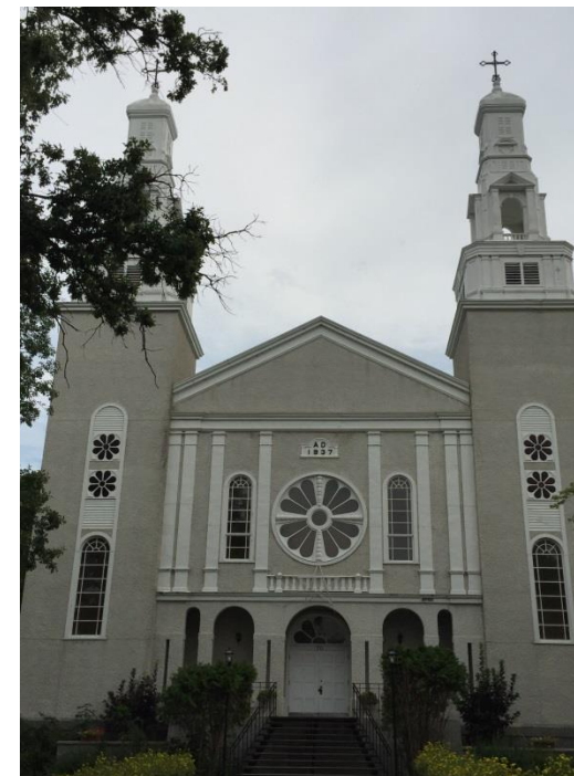
Église | Church 70 rue Saint-Pierre
